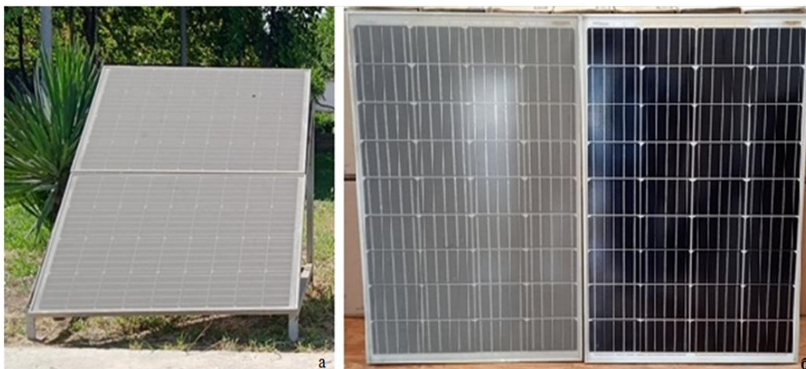
Рис. 1. Внешний вид испытуемых панелей а) панели с осажденной пылью, б) визуальное сравнение чистой панели и загрязнённой панели.
