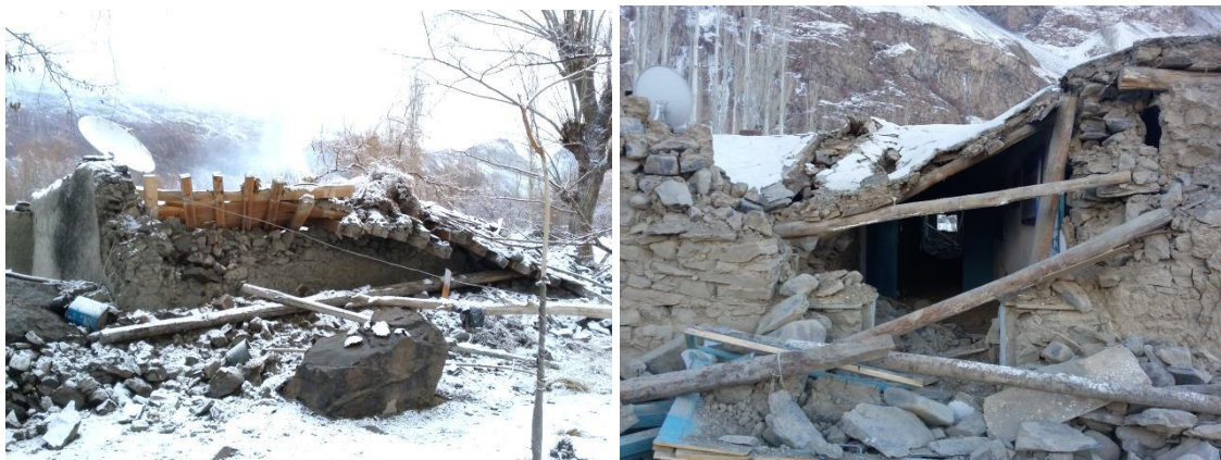
Рис. 8, 9. Повреждения жилых домов в кишлаке Гудара.
