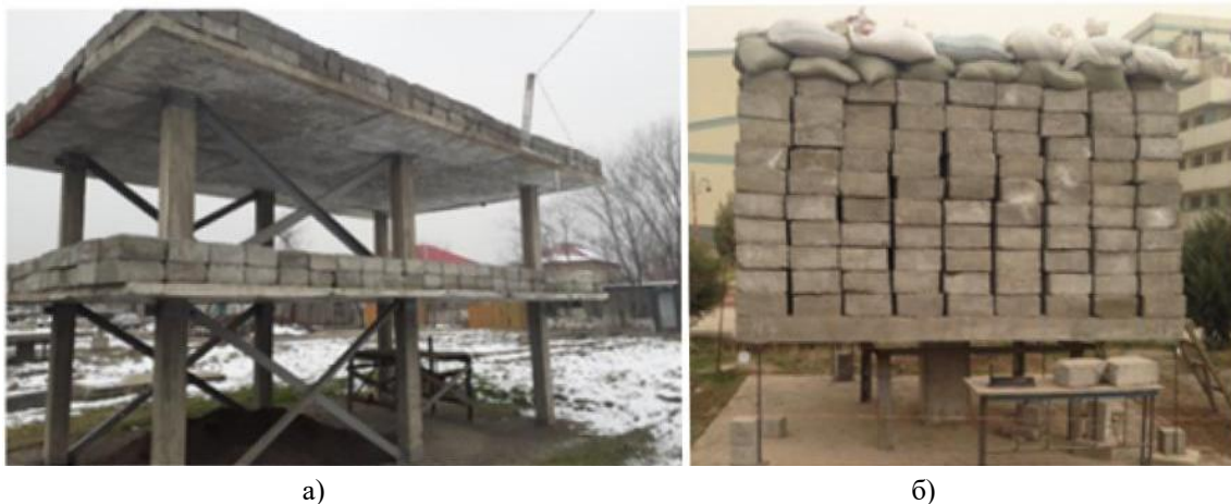
Рис. 1. Модель фрагмента двухэтажного здания с металлическими связями – а) и узел стыка плиты-балки с колонной безригельного каркаса в натуральную величину – б).
