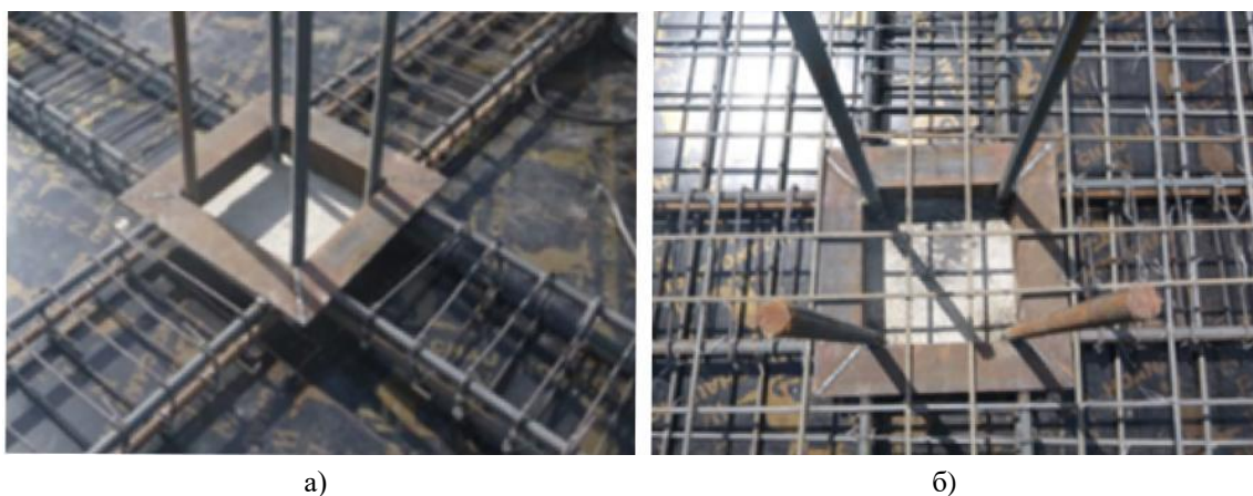
Рис. 2. Опорный столик – воротник заводского изготовления узла стыка плиты с колонной безригельного каркаса: а) – при обычном армировании стальной арматурой; б) – при смешанном армировании с АБП – базальт пластиковой арматурой и соединения с рабочей арматурой колонны в проектной отметке.
