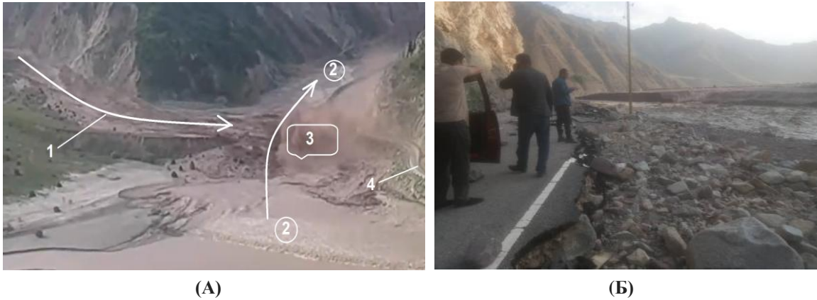
Рис. 2. А – момент схода селя: 1 – селевой поток, 2 – русло реки Сурхоб, 3 – зона перекрытия русла рек Сурхоб, 4 – автодорога. Б – разрушенная автомобильная дорога после схода селевого потока в Лахшском районе. (Источник: интернет ресурсы).
